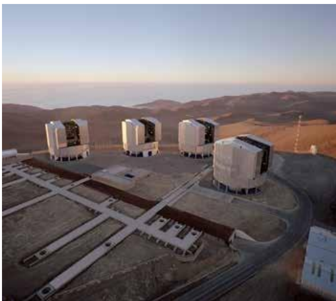
I quattro telescopi da 8.2 m del Very Large Telescope dell'ESO (European Southern Observatory), utilizzabili come interferometro (VLTI). Cerro Paranal (Cile)
